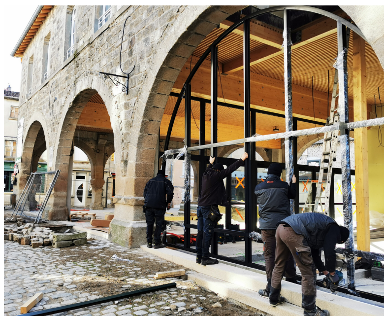
Pose des arches au mois de février
